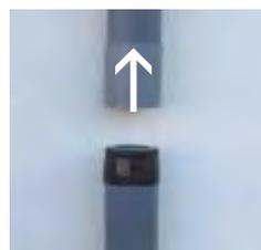
Poser le filtre anti-odeur sur la partie basse du tuyau de ventilation. Réaliser un joint de silicone sur la partie basse et sur le pourtour du filtre
