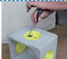
Placer un tournevis entre la languette et la collerette du diamètre voulu. Frapper sèchement sur le tournevis pour faire sauter l'opercule.
