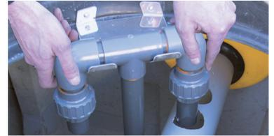
À l'aide du feillard, remonter la rallonge en tube PVC et la pompe du fond de la cuve.
