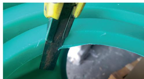
Retourner la rehausse filtrante et poser le cordon d'étanchéité fourni sur le plan de pose du corps de rehausse en contact avec la cuve.
