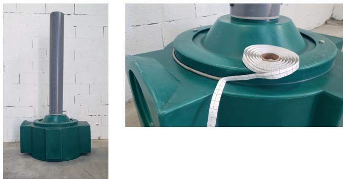
Mettre en place la rehausse sur le module d'entrée en s'alignant sur la marque réalisée précédemment. Visser les 6 vis torx 30 de fixation dans les trous pré-perçés.
