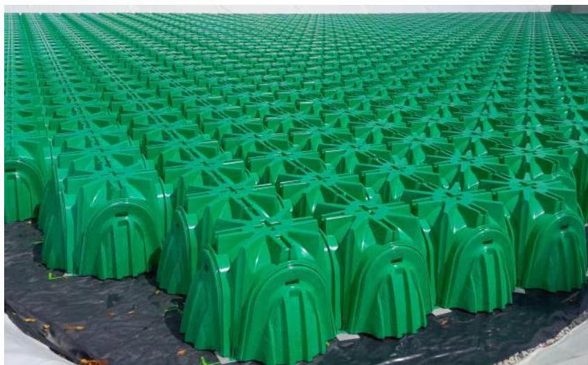
Solution Triton pour le stockage ou l'infiltration de l'eau de pluie développée par Eaux-Vives
