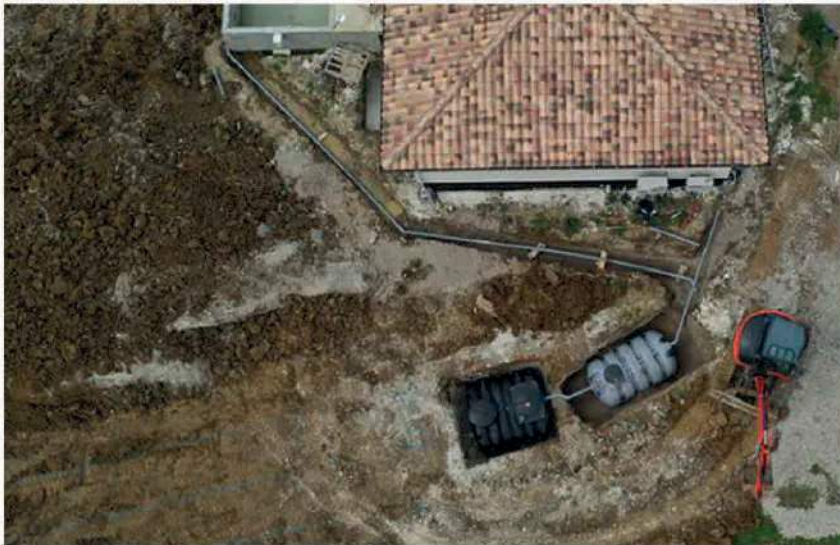
Sur le filtre compact Biomeris de Sebico, moins de 10 jours sont nécessaires pour le redémarrage de la filière de traitement en cas d'absence prolongée des occupants.
