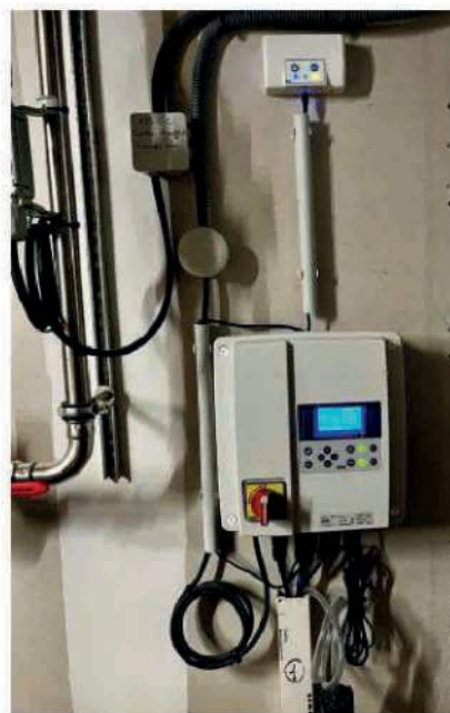
Certaines stations de relevage SFA sont livrées en série avec un coffret de commande Smart et un boîtier d'alarme filaire qui permet de déporter l'alarme jusqu'à 10 m ou 30 m.
