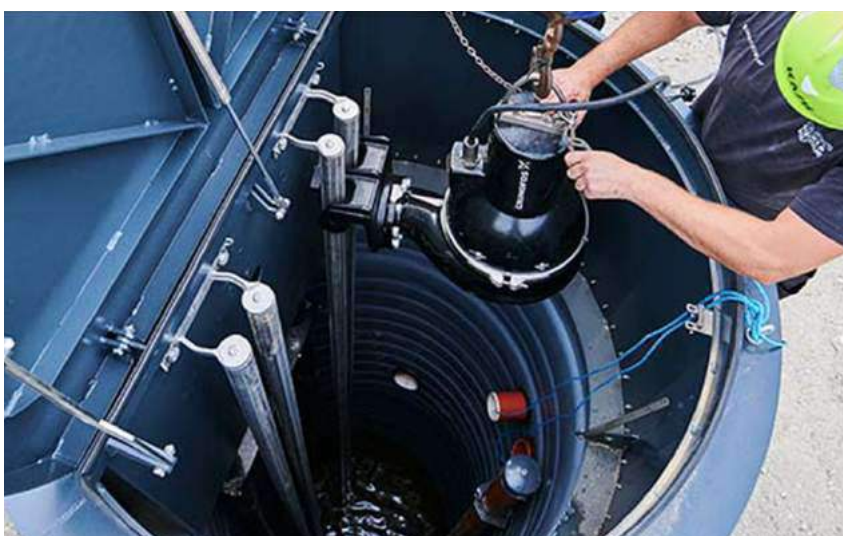
La gamme Waterlift de Grundfos contrôle et informe sur le débit de la pompe, l'humidité à l'intérieur du moteur, sa température et l'intensité.
