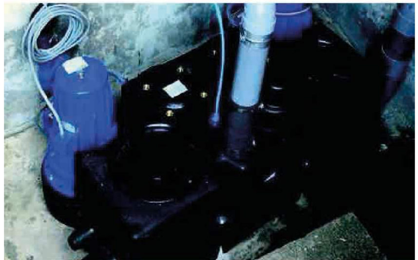
SFA a équipé un immeuble de huit appartements pour relever et raccorder l'ensemble des équipements des sanitaires au tout à l'égout. Pour ce projet, il a proposé sa solution Sanicubic 2 GR, équipée de deux pompes dilacératrices d'un débit de 17 m 3 /h pour une HMT jusqu'à 39 m.
