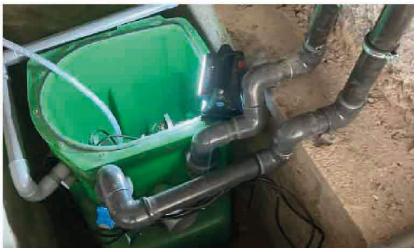
Le poste de relevage Fékafos de Jetly est destiné au relevage des effluents de la maison vers le tout à l'égout. Il est équipé au choix de pompes à roue vortex ou dilacératrice pour des débits disponibles de 6,5 m 3 /h à 30 m 3 /h selon les modèles.
