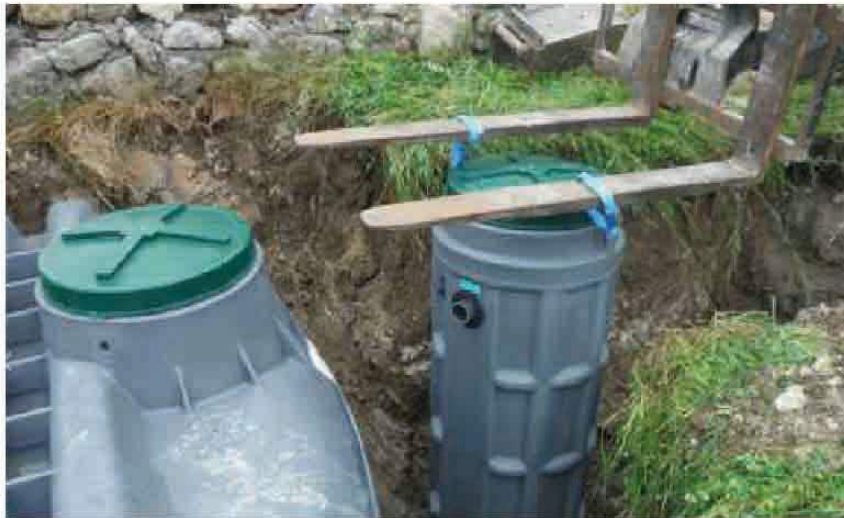
Poste de relevage Hydrorel de la marque Hydréal en PEHD Ø56 cm - Hauteur 2.14m équipé d'une pompe avec une section de passage de 35mm. Ici, placé en aval d'un filtre compact Hydrofiltre 25 EH.
