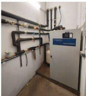
Le Village olympique à Saint-Denis est équipé d'un système de récupération d'eau de pluie.
