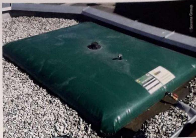
En toile PCV, les citernes souples 'standards' du Serena Group sont fabriquées à la commande et offrent de nombreuses possibilités : dimensions, accessoires, emplacement des accessoires... Elles intègrent notamment des sorties en DN50 ou DN100. Capacité de stockage maximale : 2 000 m<sup>3</sup>.
